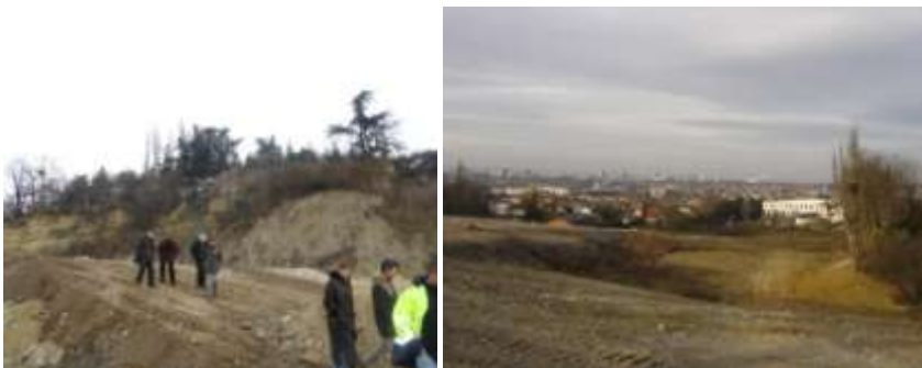
CLIS décembre 2008 , vue d'un front de taille, comblement et bassin rétention
